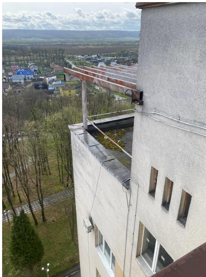
Фото 1, 2. Загальний вигляд об'єкту обстеження
