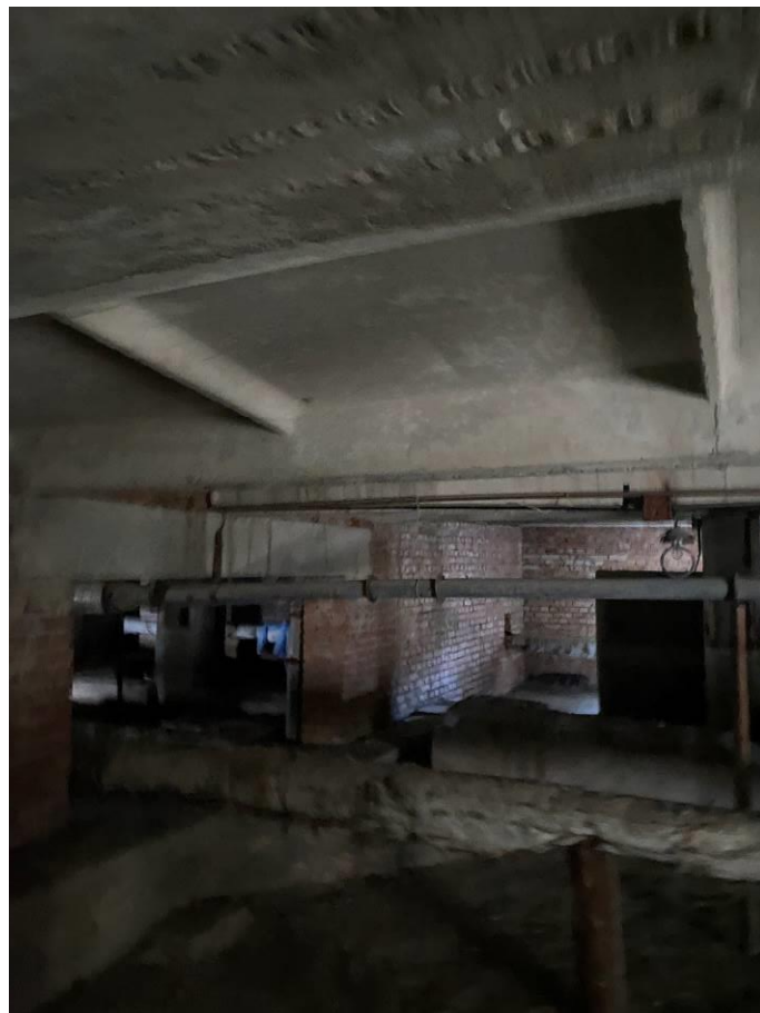
Фото 5...7. Загальний вигляд конструкцій покриття
